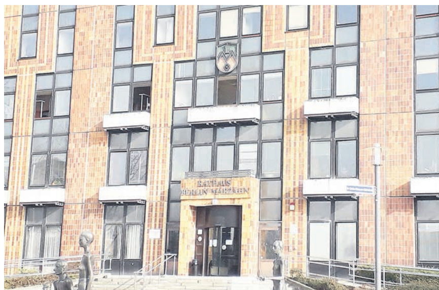
Die Blumenkästen an der Fassade bleiben im Original erhalten. Vorgesehen ist, sie zu demonstrieren, zu reinigen, erneut anzubringen und zu bepflanzen. Die Kästen aus Stahlbeton konnten schon viele Jahre nicht mehr bepflanzt werden.
