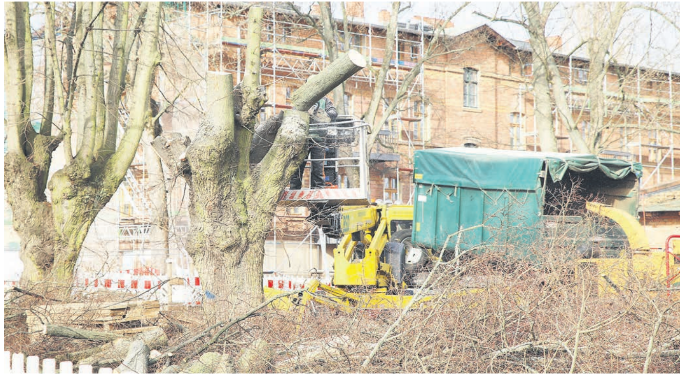
Mit einer Hebebühne und einer Kettensäge wird dieser Baum an der Alten Hellersdorfer Straße bearbeitet.
